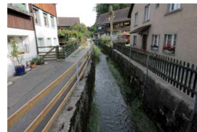
Chatzenbach bei Sandplatte mit beidseitiger Mauer
